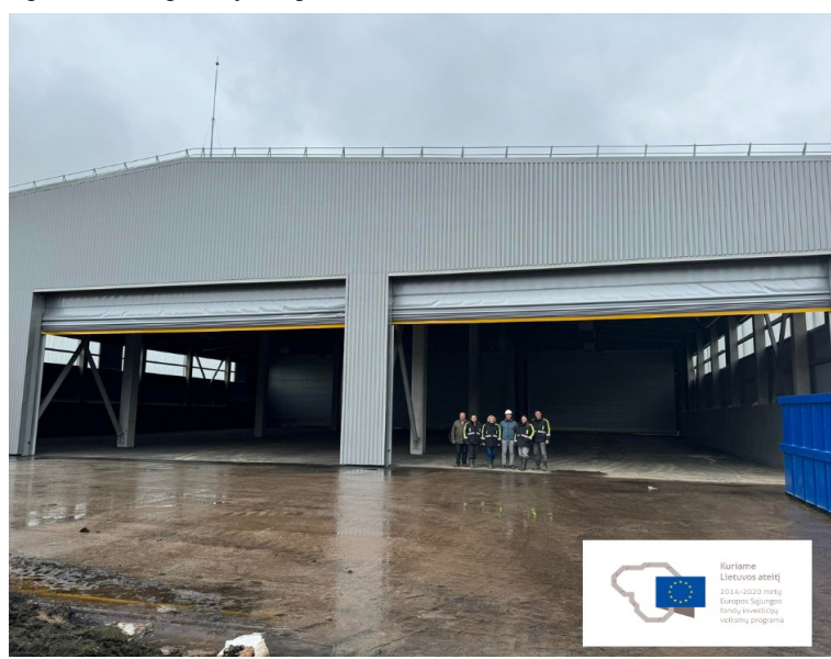
2 pav. MVA apdorojimo pastatas
