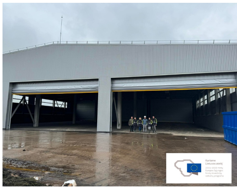
2 pav. MVA apdorojimo pastatas
