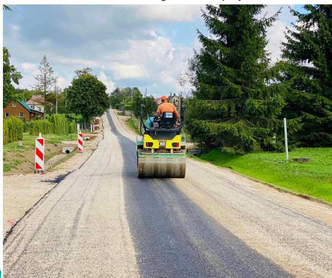
Baigtas Vabalų gyvenvietės asfaltavimas
